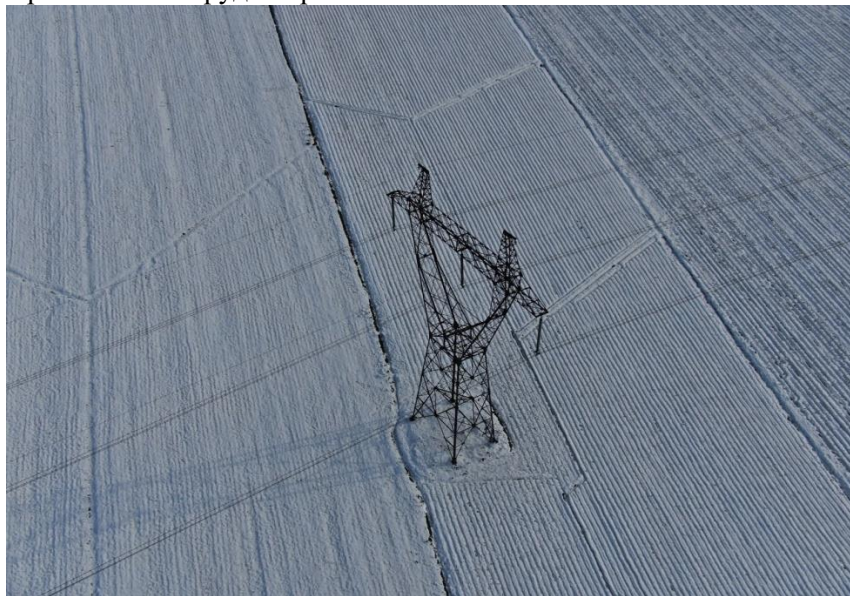
Рис. 1. Мониторинг ЛЭП с помощью фотокамеры БПЛА
