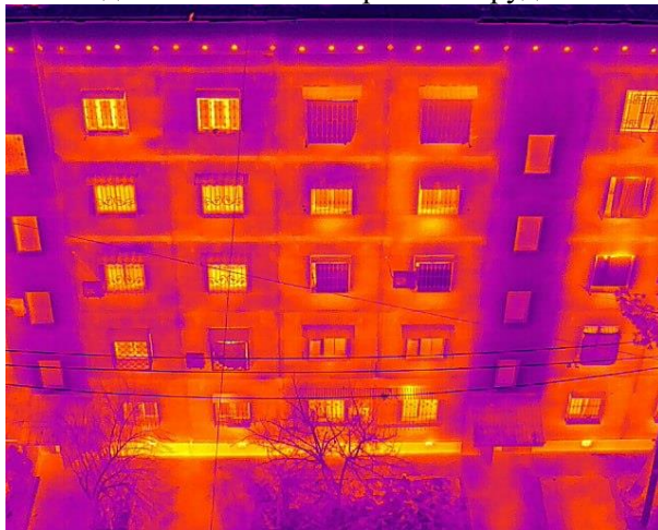
Рис. 1. Мониторинг потери тепла жилого здания с помощью тепловизора
