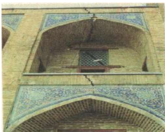
3-rasm. Ikkinchi qavatdagi yoriqlar (fasadning g‘arbiy qismi-birinchi hujralar)
